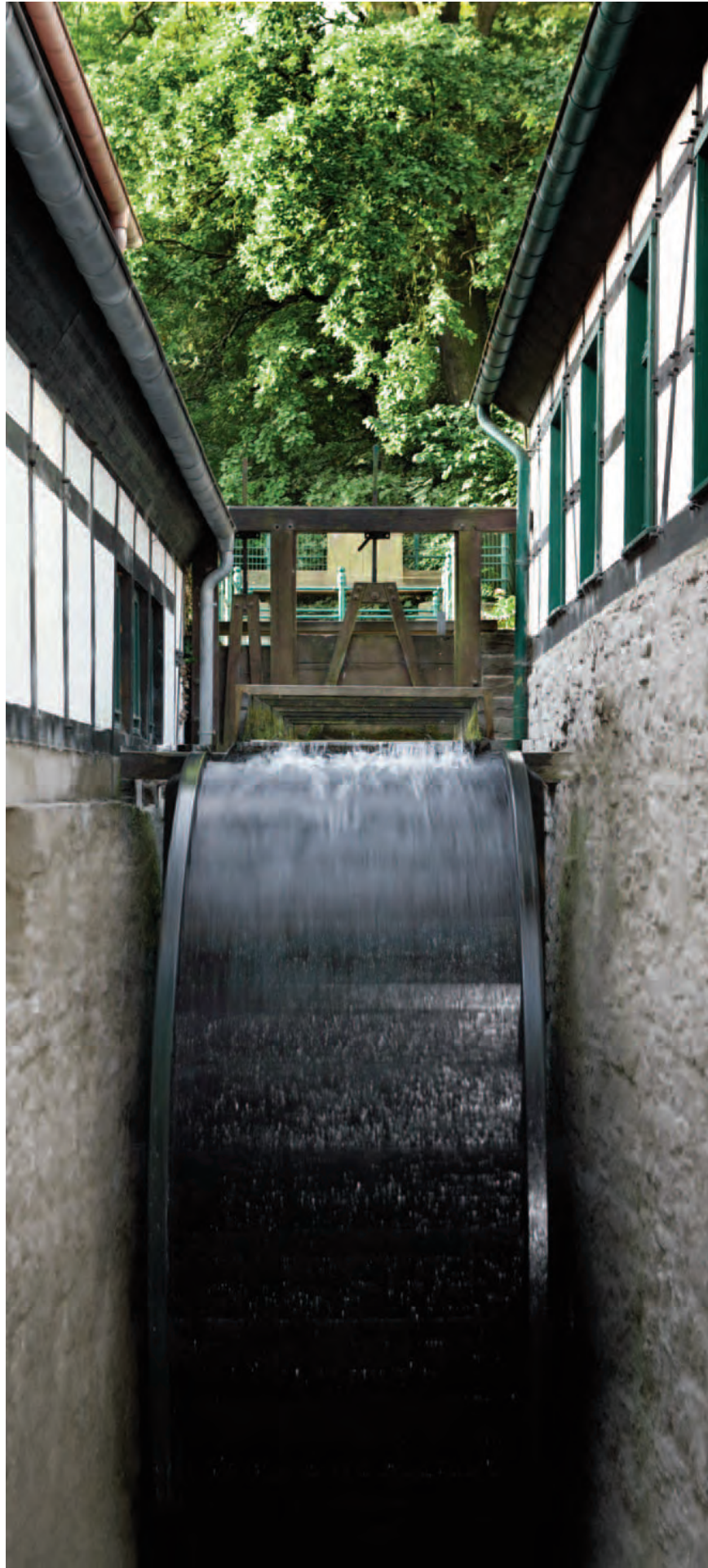
Wasser wird zur Maschinenkraft: Wehr und rekonstruiertes Wasserrad an einem ehemaligen Maschinen- haus der Mittleren Fabrik.
